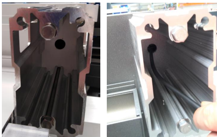
Rys. 8b. Otwory dla okablowania
